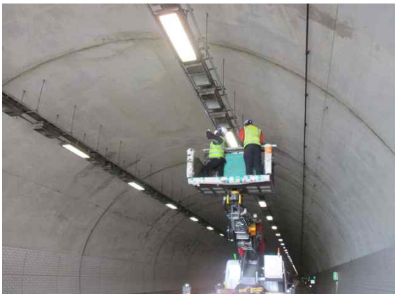
고소작업차를 이용한 외관조사 현황①
