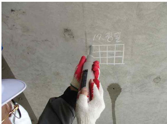
반발경도 측정 현황(측벽부)①
