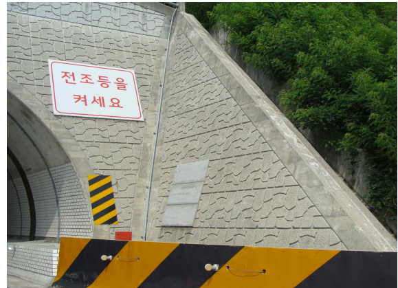
시점부 옹벽 전경
