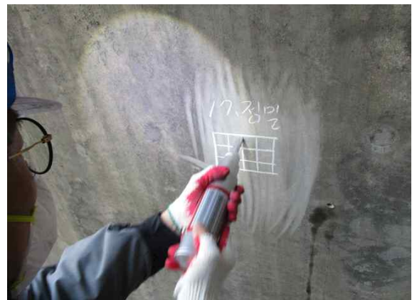
반발경도 측정 현황(측벽부)②
