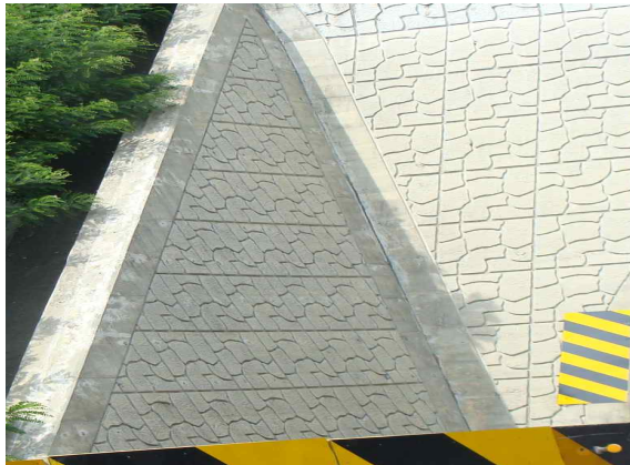
시점부 옹벽 전경
